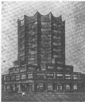
Garage alemán, con ascensores descendentes y ascendentes, construido por el arquitecto Wickop.
